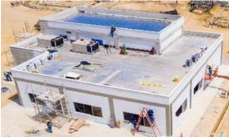
Edificio Administrativo y Centro de Control – Agosto de 2016
