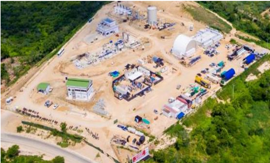
Avance SPEC. Construcción On Shore – Agosto de 2016
