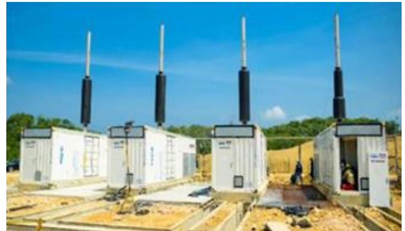
Instalación chimeneas y generadores – Agosto de 2016
