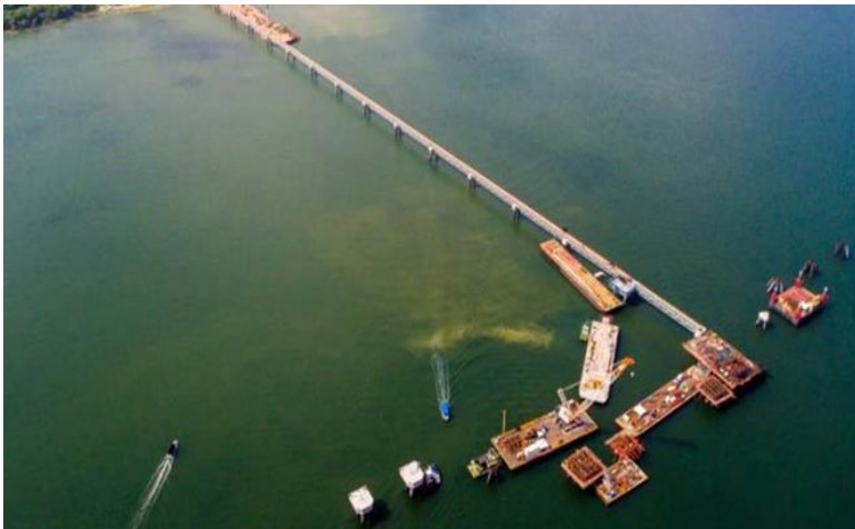
Construcción off shore – Agosto de 2016
