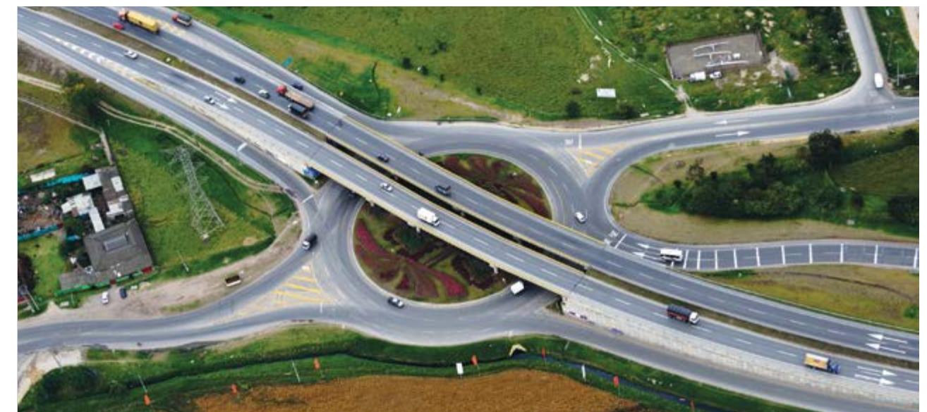
1 Enlace a desnivel en el inicio de la Variante de Madrid, ubicada en el municipio de Madrid, Cundinamarca. Concesiones CCFC S.A.S.
