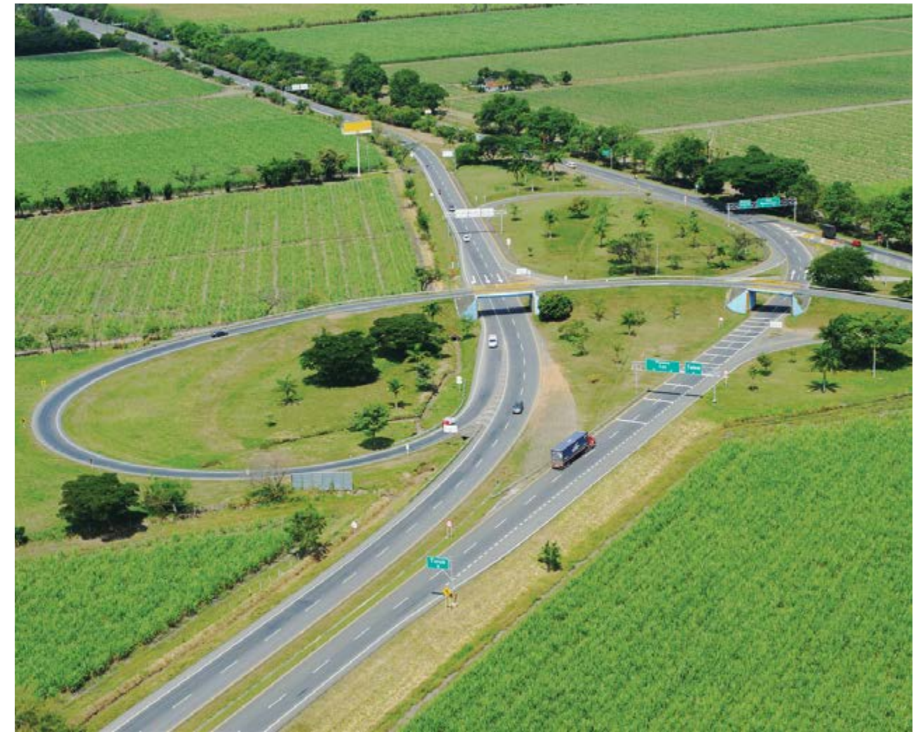
📍 Paso Elevado Sur Tuluá, ubicado en el municipio de Tuluá, Valle del Cauca. Proyectos de Infraestructura - Pisa S.A.
