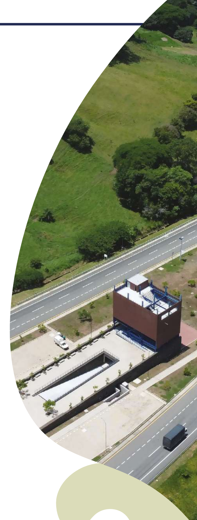
Área de Servicio de Pacífico 1, Covipacífico, Bolombolo, Antioquia, Colombia
