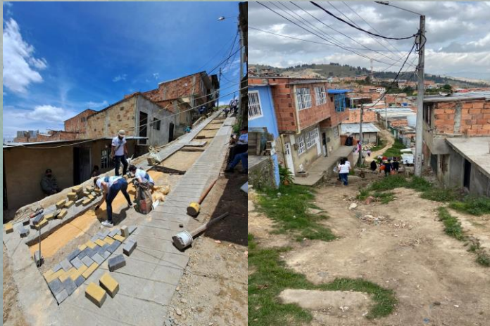
CONSTRUCCIÓN DE VIAS FUNDACIÓN TECO
